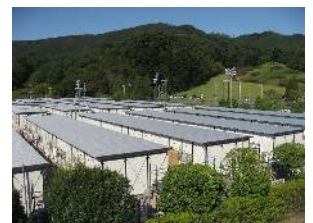
総合運動場内の仮設住宅
