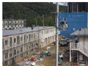
野球場に建設中の3階建て仮設
