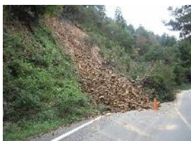
台風15号による土砂崩れ
